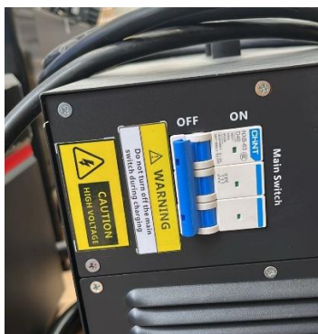
Figura 42 – Disjuntor Principal
